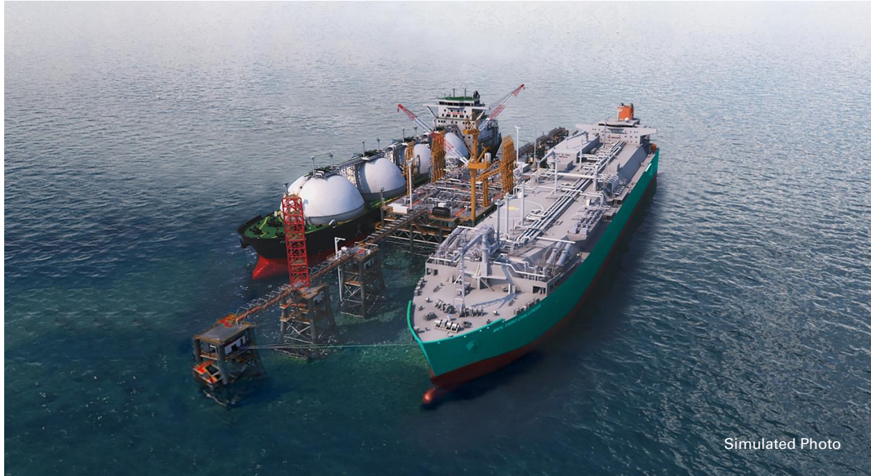
Figure 5. The Hong Kong offshore LNG terminal
